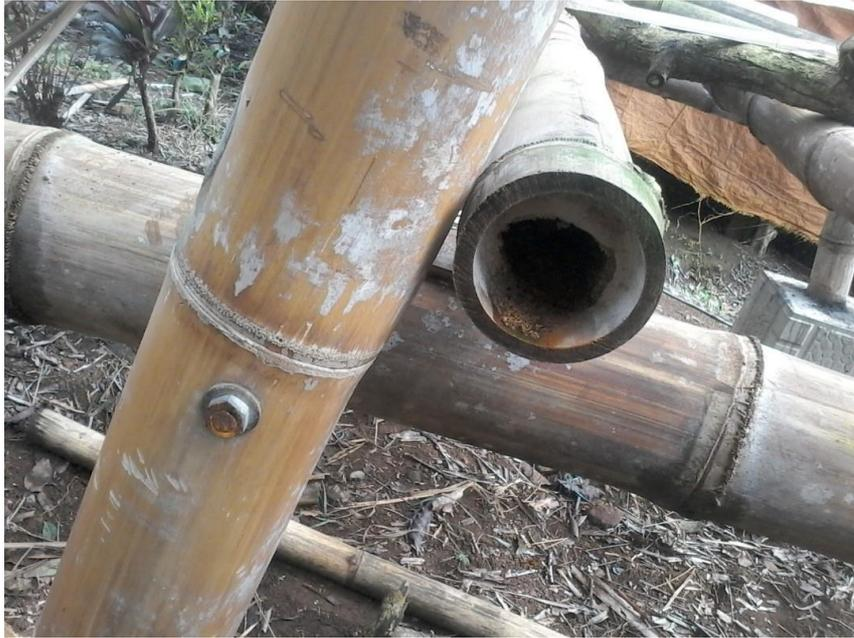
**Gambar 5.**Konstruksi pada tiang utama menggunakan baut besi sebagai pengunci.
