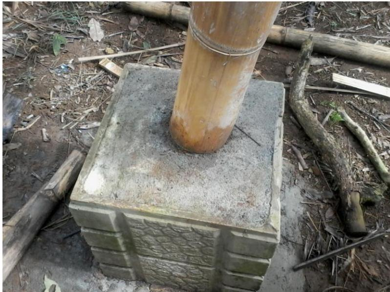
**Gambar 4 .Konstruksi pondasi dikerjakan dengan menempatkan beton pra cetak.
