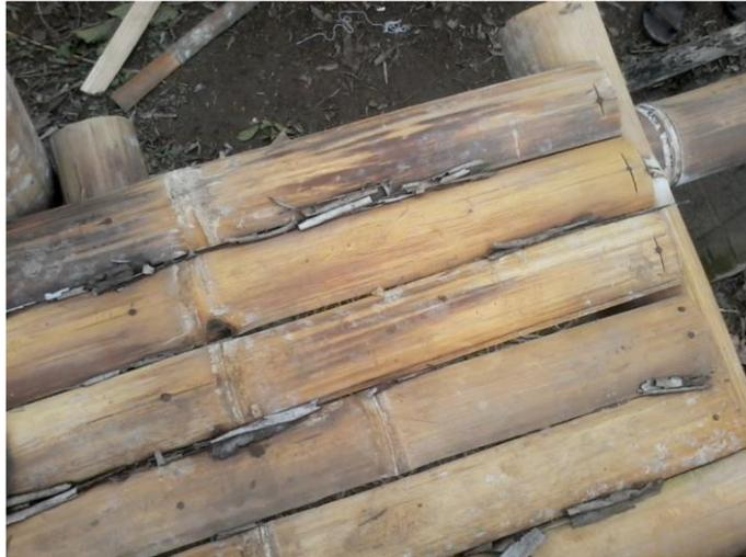
**Gambar 7. Konstruksi pada bagian lantai menggunakan bilah bambu yang dibelah dan digunakan paku sebagai penyatunya.**
