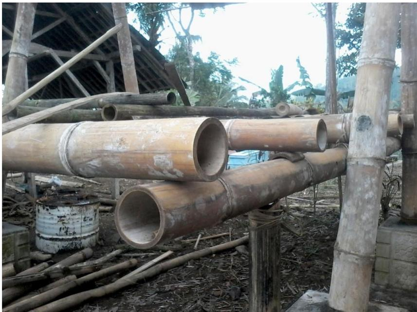
**Gambar 6.**Konstruksi pada tiang utama menggunakan baut sebagai pengunci.
