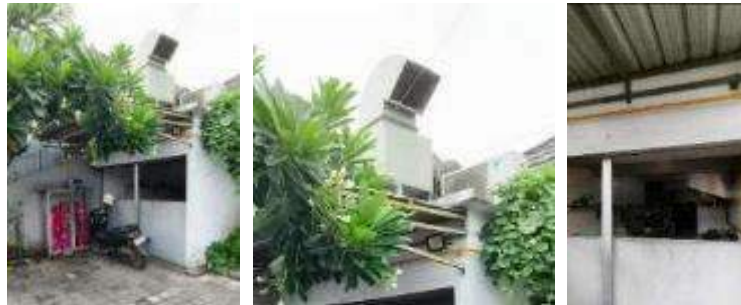
Gambar 11. Penggunaan Cerobong Asap untuk Transfer Udara Panas [Sumber: Giri, 2024]
