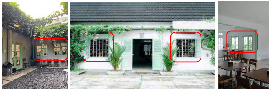
Gambar 9. Ritme Jendela sebagai Ventilasi Silang [Sumber: https://www.google.com/maps , diakses 10 April 2024]
