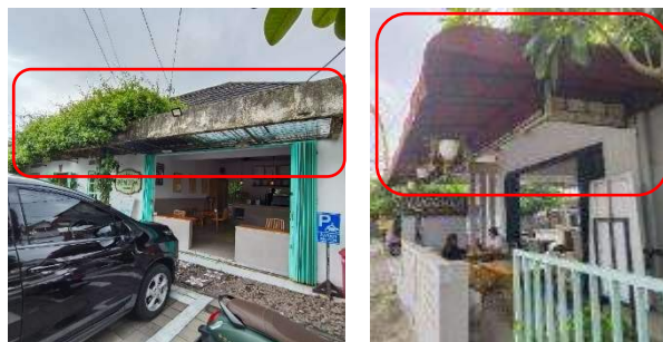
Gambar 13. Penambahan Kanopi di atas Pintu Harmonika [Sumber: Giri, 2024]
