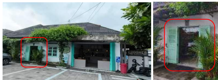
Gambar 23. Penerapan Gaya Indische Empire pada Fasad Bangunan [Sumber: Giri, 2024]
