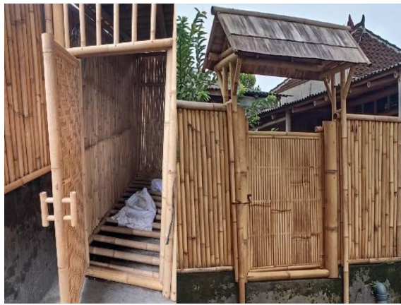
Gambar 4. Contoh Pemanfaatan Bambu pada Pintu [Sumber: Dokumentasi Penulis, 2022]
