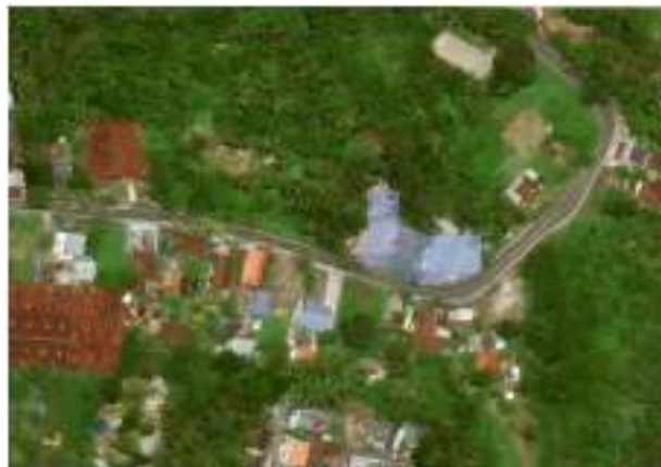
Gambar 1. Eksisting Lokasi TPS Desa Sibang Kaja [Sumber: google maps, 2023]
