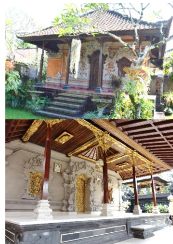
Gambar 2. Contoh Bentuk Bangunan Tradisional Bali dengan Penerapan Konsep Terbuka, Ragam Hias dan Material Alami [Sumber: Dokumentasi Pribadi]
