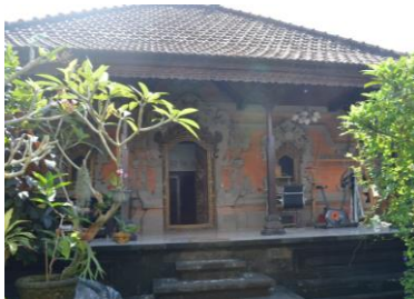
Gambar 3. Contoh Bangunan Tradisional Bali dengan Penerapan Penghawaan dan Pencahayaan Alami [Sumber: Dokumentasi Pribadi]
