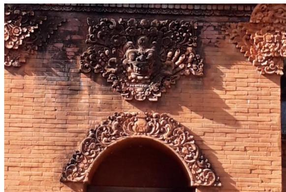
Gambar 10. Tampak detail ukiran pada candi kurung Puri Agung Karangasem. Bahan terbuat dari bata merah termasuk badan candinya. Disamping restorasi juga ada proses penambahan ukiran. Sumber: I Ketut Muka P, 2018.
